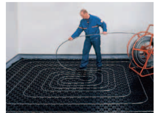
Рис. 3. Процесс укладки «теплого пола».
