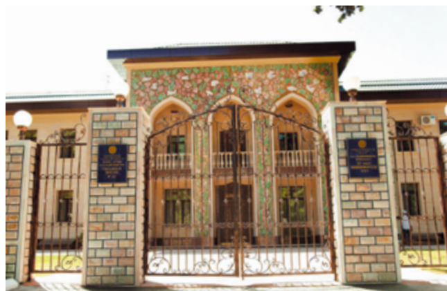
Интернат им. А.П. Хлебушкиной, г. Ташкент Общая мощность — 500 кВт
